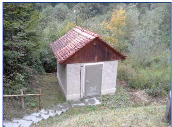
La STAP (station de pompage) de Cuvy
