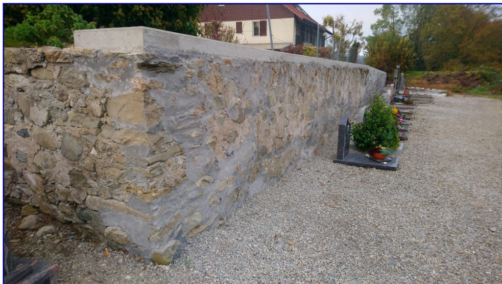
Mur du cimetière de Villarzel rénové
