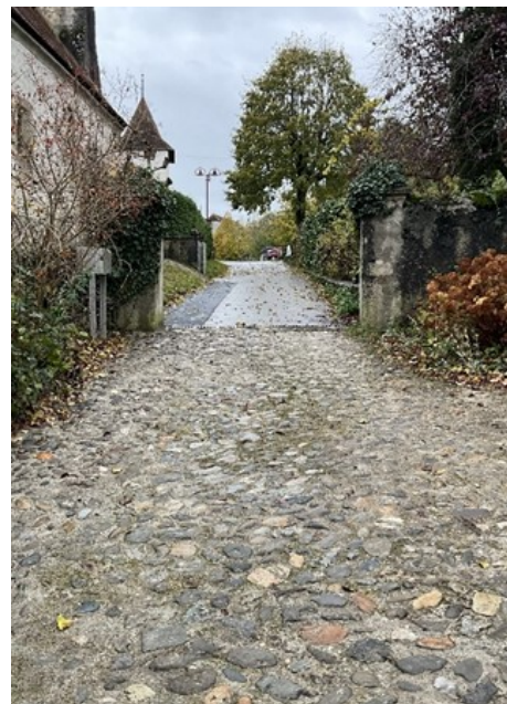
Fermeture fouille, réfection de la route et remise en place terre végétale devant église.
