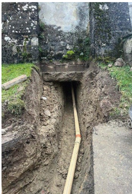
Fouille et passage de mur église. Mise en place évacuation EU.
